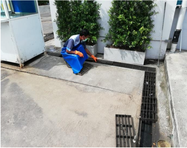
รูปที่ 84 โครงการมีการติดตั้งตะแกรงที่บ่อพักน้ำสุดท้ายของจุดระบายน้ำ และทำความสะอาดท่อระบายน้ำ บ่อพักน้ำ และบ่อดักมูลฝอยเป็นประจำอย่างน้อยปีละ 2 ครั้ง
